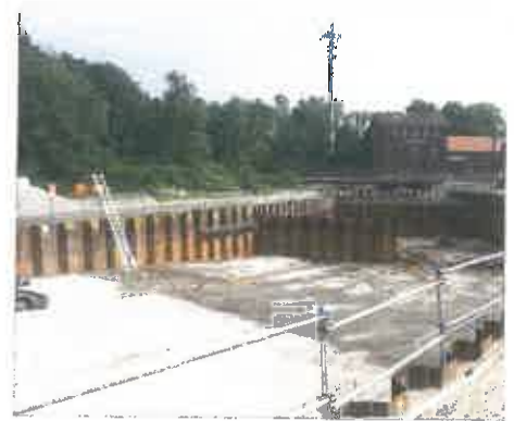
Baustelle Tunnel in Verlängerung Franz-Schütte-Allee
