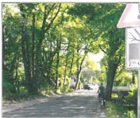
Unzureichend ausgebaute Nebenanlagen ...
