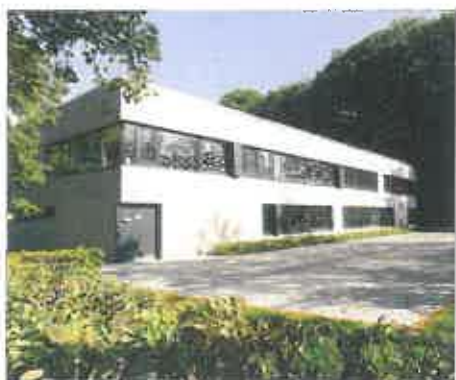
Neubau Grundschule Oberneuland
