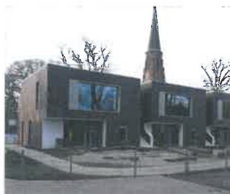
Neubau Evangelischer Kindergarten
