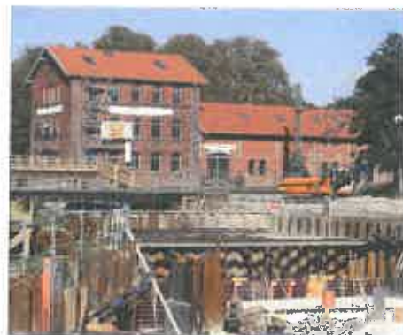
Tunnelbau am Oberneulander Bahnhof
